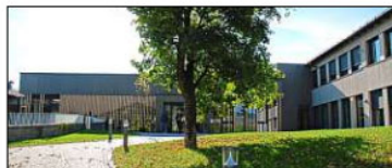
Ein Musterbeispiel für Nachhaltigkeit ist die Grundschule Hauzenberg. Der alte Bestand wurde mit Bedacht saniert. Dabei kam viel Holz zum Einsatz.
